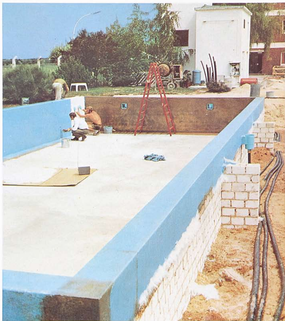
Zuerst werden Rand und Seitenwände umlaufend beschichtet. Zwei Pfeiler stützen die 14 m lange Seitenwand zusätzlich. Die PVC-Rohre liegen 1,25 m unter dem Niveau.
