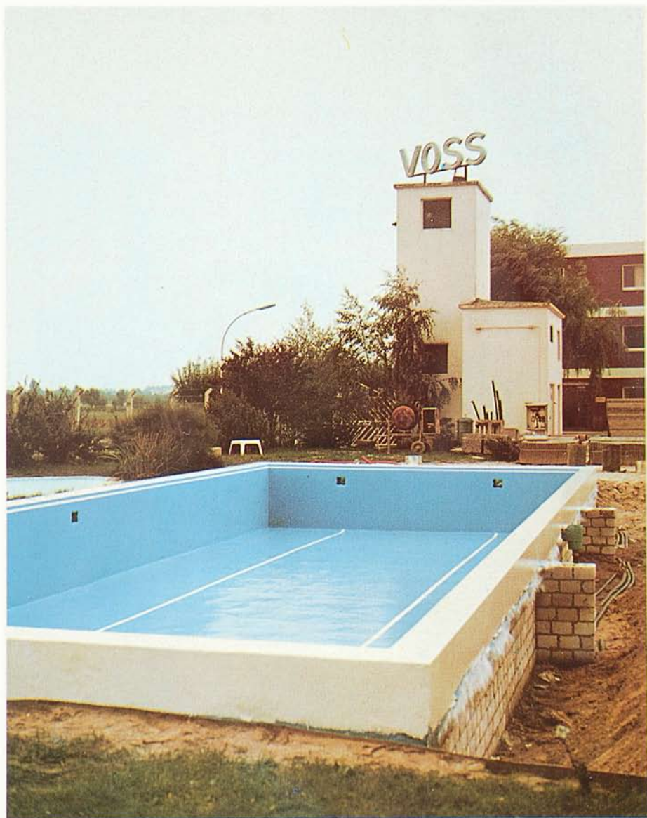
Ein Becken mit Betonsohle und Kalksandsteinen ist fertig beschichtet. Der Rand ist weiß abgesetzt. Um den wechselnden Windrichtungen Rechnung zu tragen, sind die 14 m langen Seitenwände ebenfalls mit Oberflächenaugern ausgestattet.
