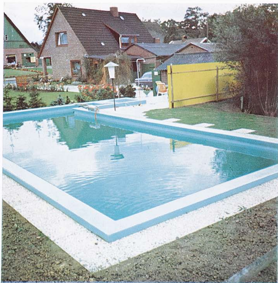
Dieses Becken ( 10 \times 5 \times 1,50 m) wurde nach der Spanplatten-Methode erstellt. Die Aussparung auf einer Seite wurde als Treppe ausgebildet. Vor der Treppe ist eine Duschwanne mit Brause installiert. Die Umrahmung besteht aus Waschbeton-Gehwegplatten. Der etwas erhöhte Rand ist günstig gegen hereinwehende Blätter und Staub.
