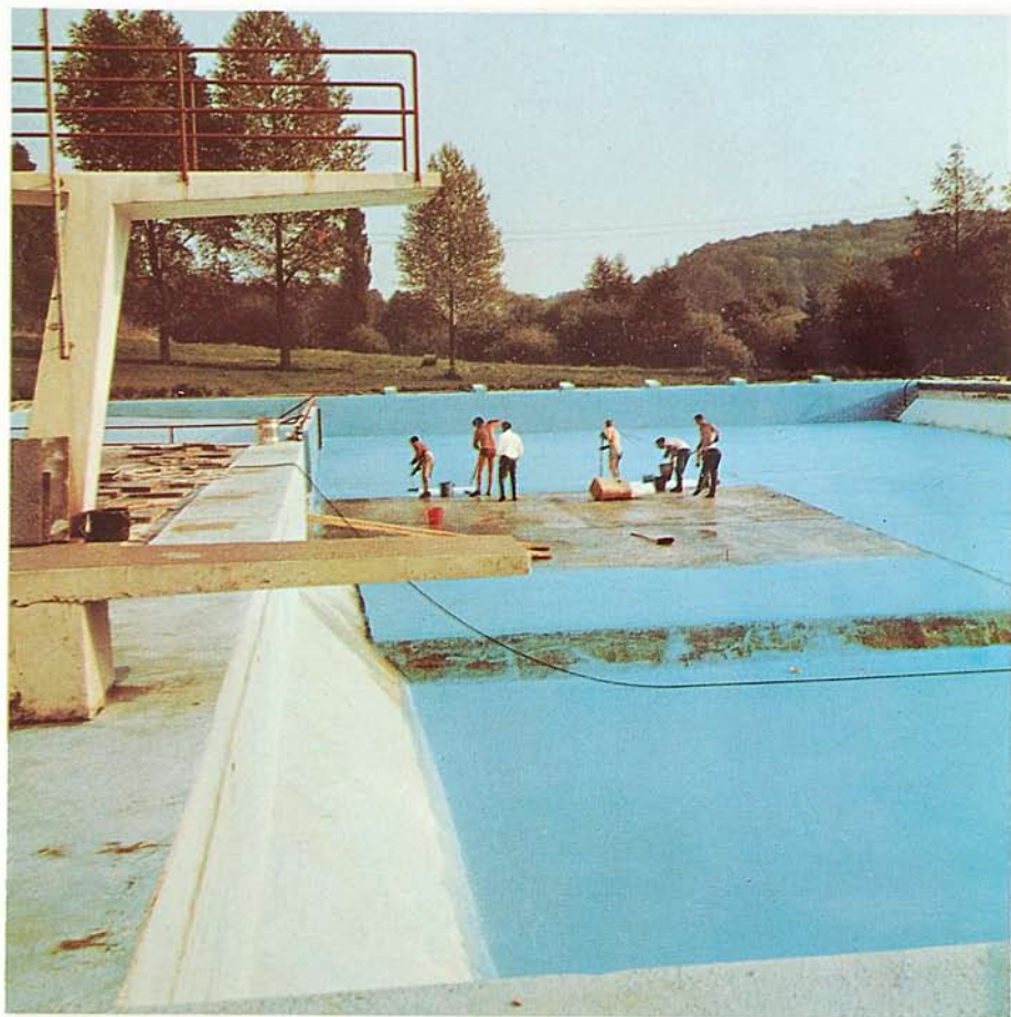
Großbeckenbeschichtung in Oberramstadt/Darmstadt mit dem Ziel, die Wartungskosten des Betonbeckens zu senken und Leckagen auszuschalten. Die Dehnungsfugen werden durch eine besondere Verlegetechnik in die neue Beckenhaut mit einbezogen. Die Fugen wurden etwa 3 cm tief ausgenommen und ebenfalls nahtlos in Halbkreisform mit austapeziert.
