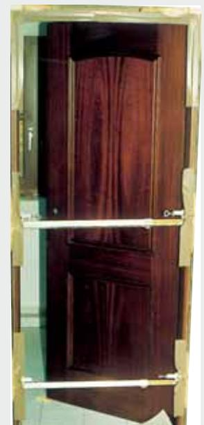
Beim Einsetzen einer Türzarge ist es wichtig, nur einige begrenzte Bereiche mit RAPID 2002 zu füllen, damit der Druck auf die Zarge nicht zu groß wird, diese verformt. So kann der Schaum über den Kontakt zur Luftfeuchtigkeit aushärten.
